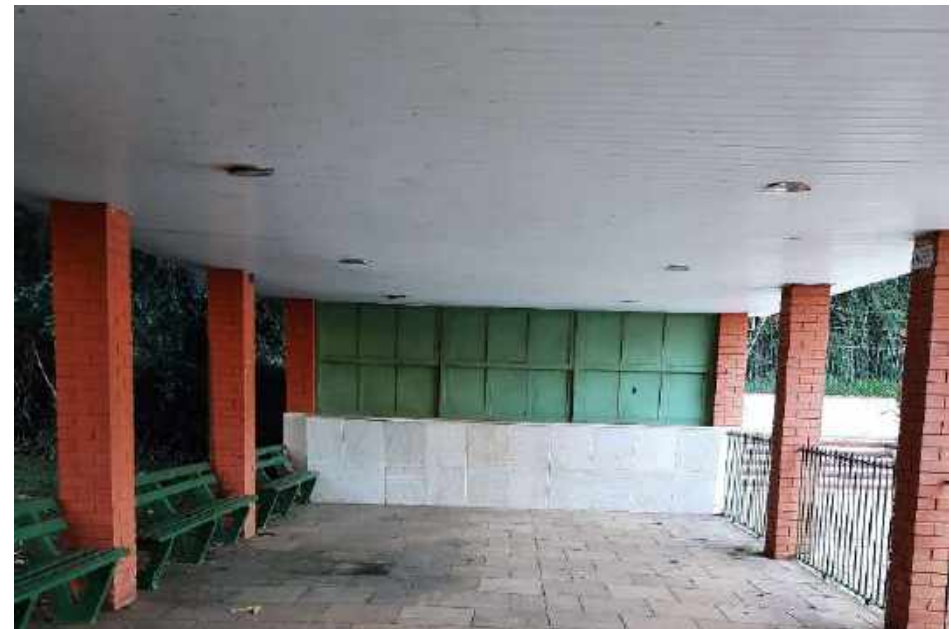
Bar/restaurante da Piscina
