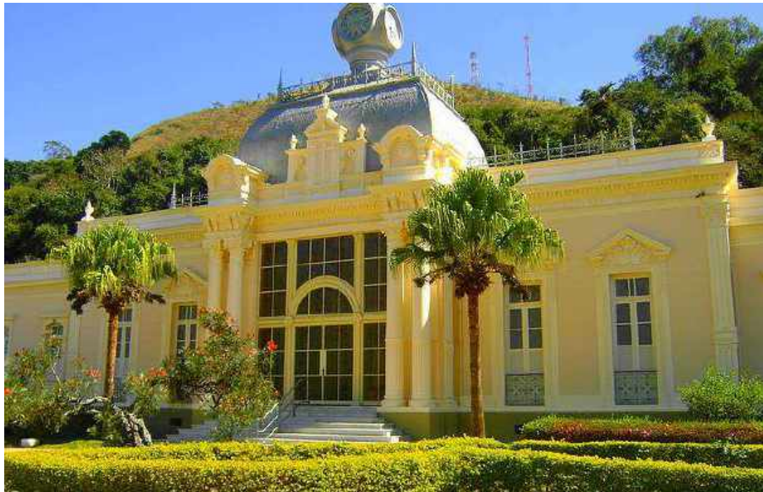
Fachada do Balneário Hidroterápico
